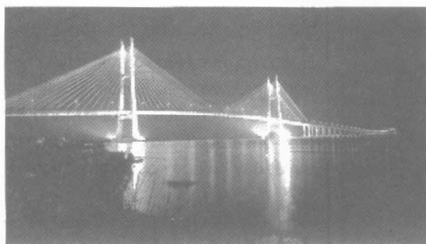
Hình 91. Cầu Mi Thuận bắc qua sông Tiên (khánh thành ngày 21 – 5 – 2000)
